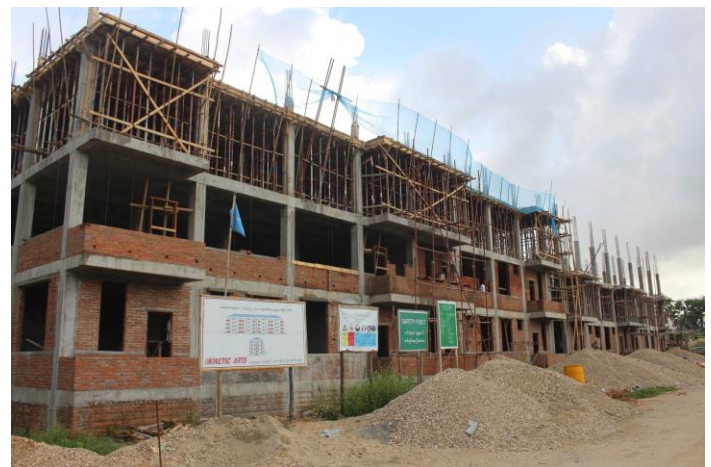
ဝန်ထမ်းအိမ်ယာ (၄)ထပ်ဆောင် ဆောက်လုပ်ခြင်း (၁၆.၁၁.၂၀၁၉)
